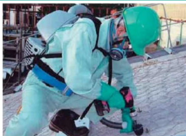
集じん回収（高性能真空掃除機）
