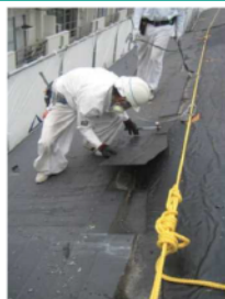
スレートの除去
